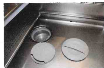
上の写真と同様に中村氏が「ステンレスにそぐわない」と指摘した、排水目皿と排水のふた
