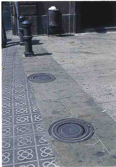
車止めは油圧式で地中に埋設されるようになっていて、時間帯によって歩行者専用になったり、自動車が通行できるようになったりする
