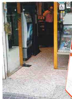
出入口に段差がなく、右側入口にマークがある
