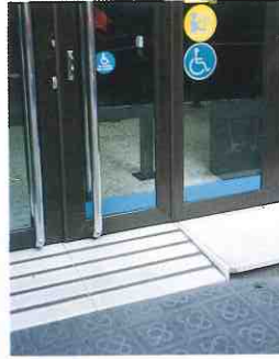
スロープが設置されている銀行の出入口
